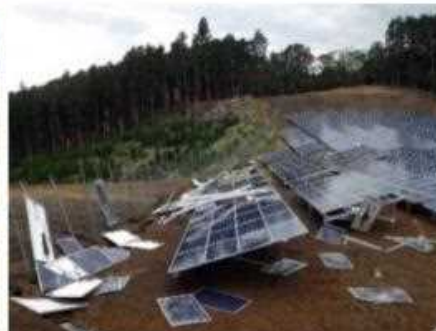
【図2】 台風の強風による事故被害
