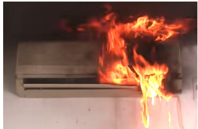
内部洗浄の不備による火災事故の再現映像
