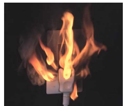
トラッキング現象による発火
