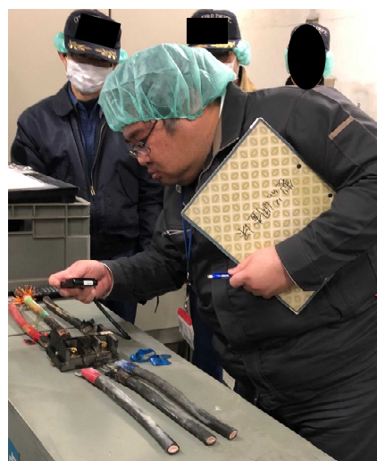
例2 焼損した端子台の調査
