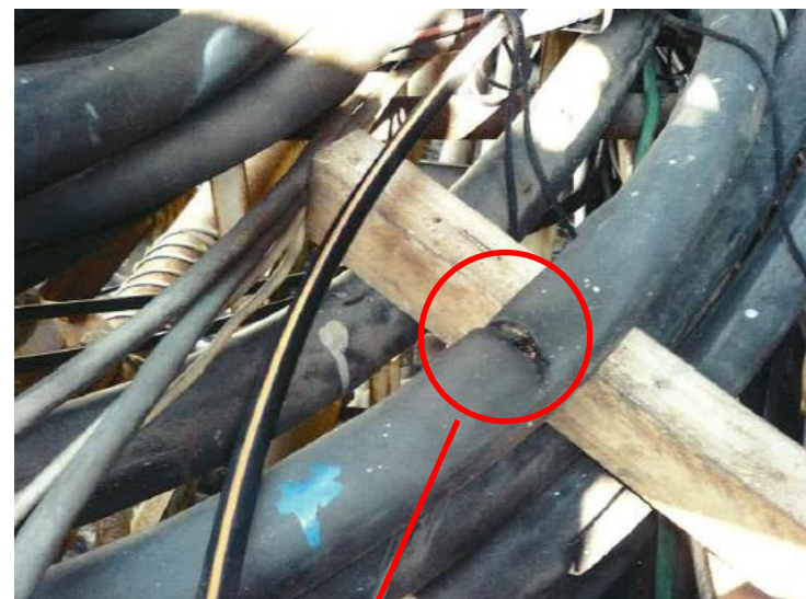
被災時作業状況
