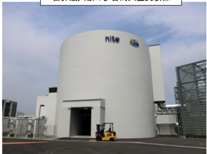
世界最大級の多目的大型実験棟
