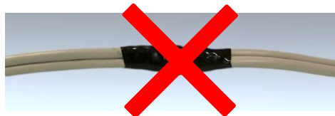
(写真) 断線部の補修
